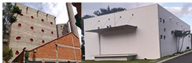
Figura 2. Edifícios anexados aos conjuntos existentes. À esquerda o SESC Pompéia e à direita o Conjunto KKKK.
