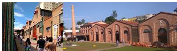
Figura 1. Edifícios históricos restaurados. À esquerda o SESC Pompéia e à direita o Conjunto KKKK.
