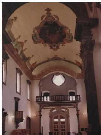
Figura 3 - Forro antes do incêndio
