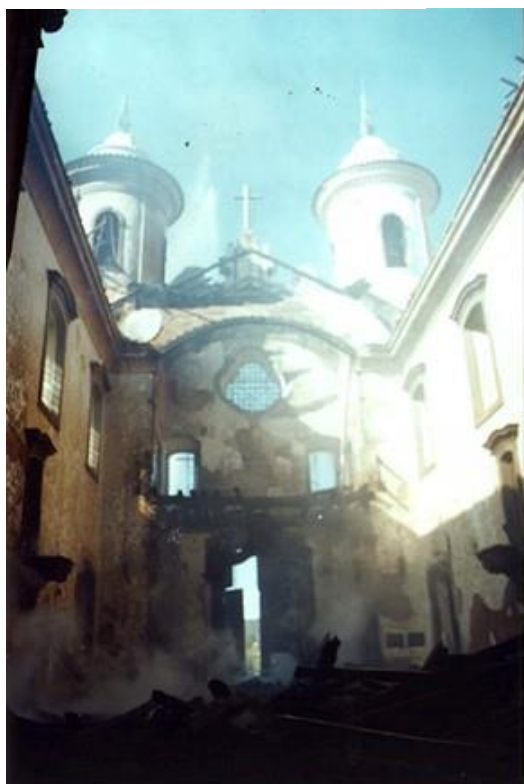
Figura 2 - Interior da igreja após incêndio
