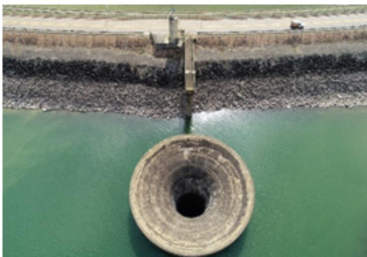
Além das barragens propriamente ditas, os drones também podem ser utilizados para inspeções das estruturas anexas, dentre elas, podem ser citados os vertedores, canais de aproximação e de fuga, bacia de dissipação e eclusas. Nestes tipos de estrutura, a obtenção de imagens por drone é importante, já que não seria obter imagens de alguns ângulos com detalhes.
