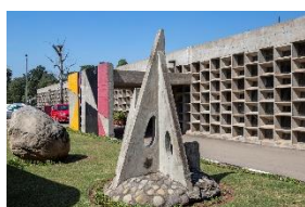
Figura 1: Escola de Arquitetura de Chandigarh Fonte: archdaily.com
