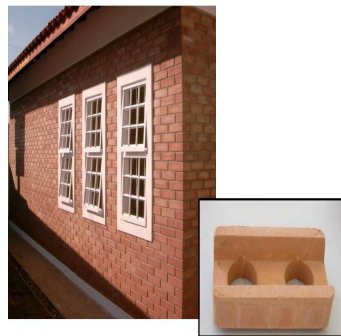
Fig. 4 – Construção com solo cimento (fonte: https://portalvirtuhab.paginas.ufsc.br/alvenaria-de-bloco-de-solo-cimento/ )
