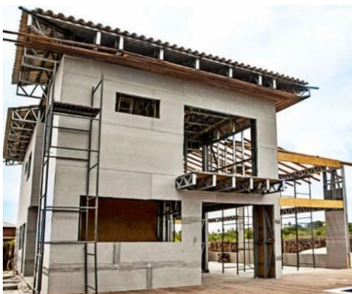
Fig. 3 – Casa em steel frame (fonte: PEREIRA, 2018)
