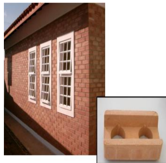
Fig.4 – Construção com solo cimento (fonte: https://portalvirtuhab.paginas.ufsc.br/alvenaria-de-bloco-de-solo-cimento/ )
