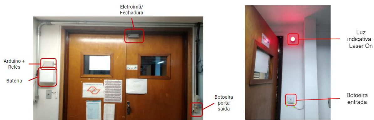
Figura 3 – Montagem do sistema de Interlock
