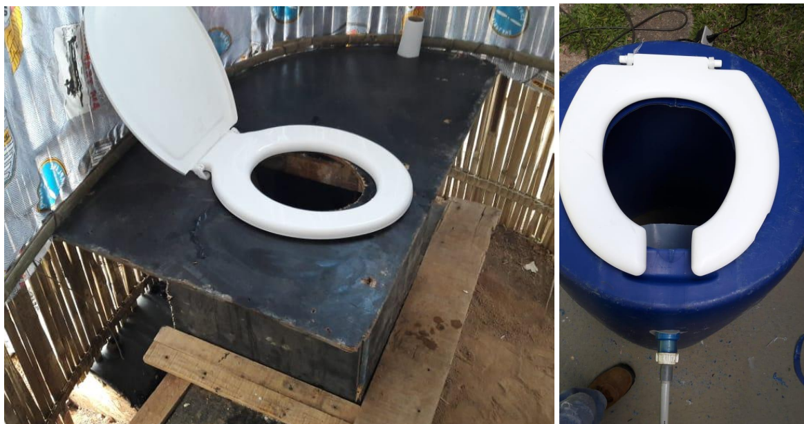
Figura 2: A) Banheiro seco compostável caracol desenhado pelo Hiroshi da Ecovila Clareando na oficina de bioconstrução em bambu. B) Primeiro protótipo com separador de urina. Fonte: Arquivo pessoal do Juliano Fujita.
