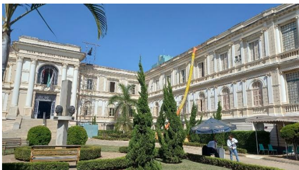
Fig. 1 – Casa da Saúde em obras.
