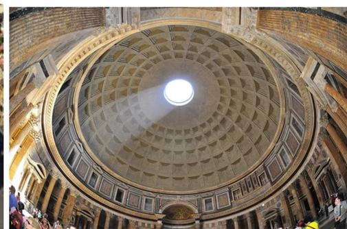
*Figura 1.2: Interior da cúpula do pantheon. Visão do óculo e caixões.*
