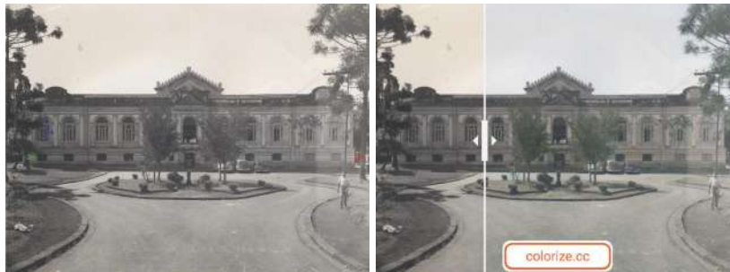
Imagem 4: Colorização da fachada
