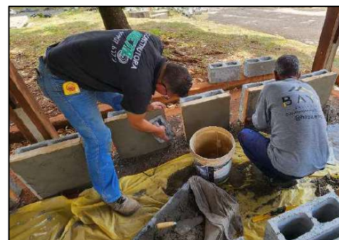
Figura 2 – Aplicação de argamassa com vermiculita.
