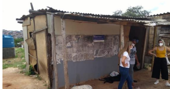
Figura 3: antiga sede da comunidade, em 2020. Fonte: acervo autoras
