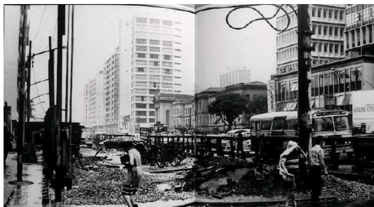
Figura 4 : Obras de alargamento da Avenida em 1991. FONTE: D'Alessio; Soukef; Albarello, 2002, Avenida Paulista: a síntese da metrópole, p.80-81
