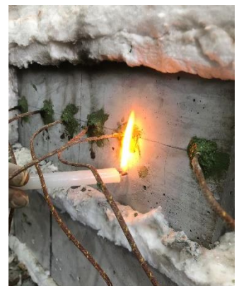
Figura 4 – fonte de calor para solidificação da massa refratária
