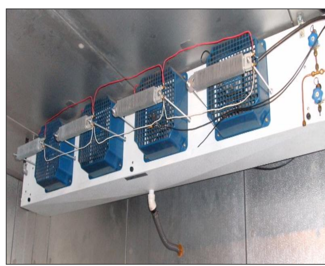
Figura 1. Câmara de secagem com túnel de ar forçado
