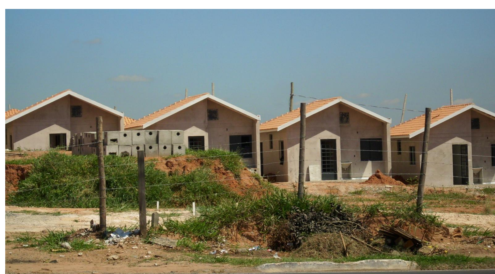
Residencial Parque Campinas em fase de construção.
