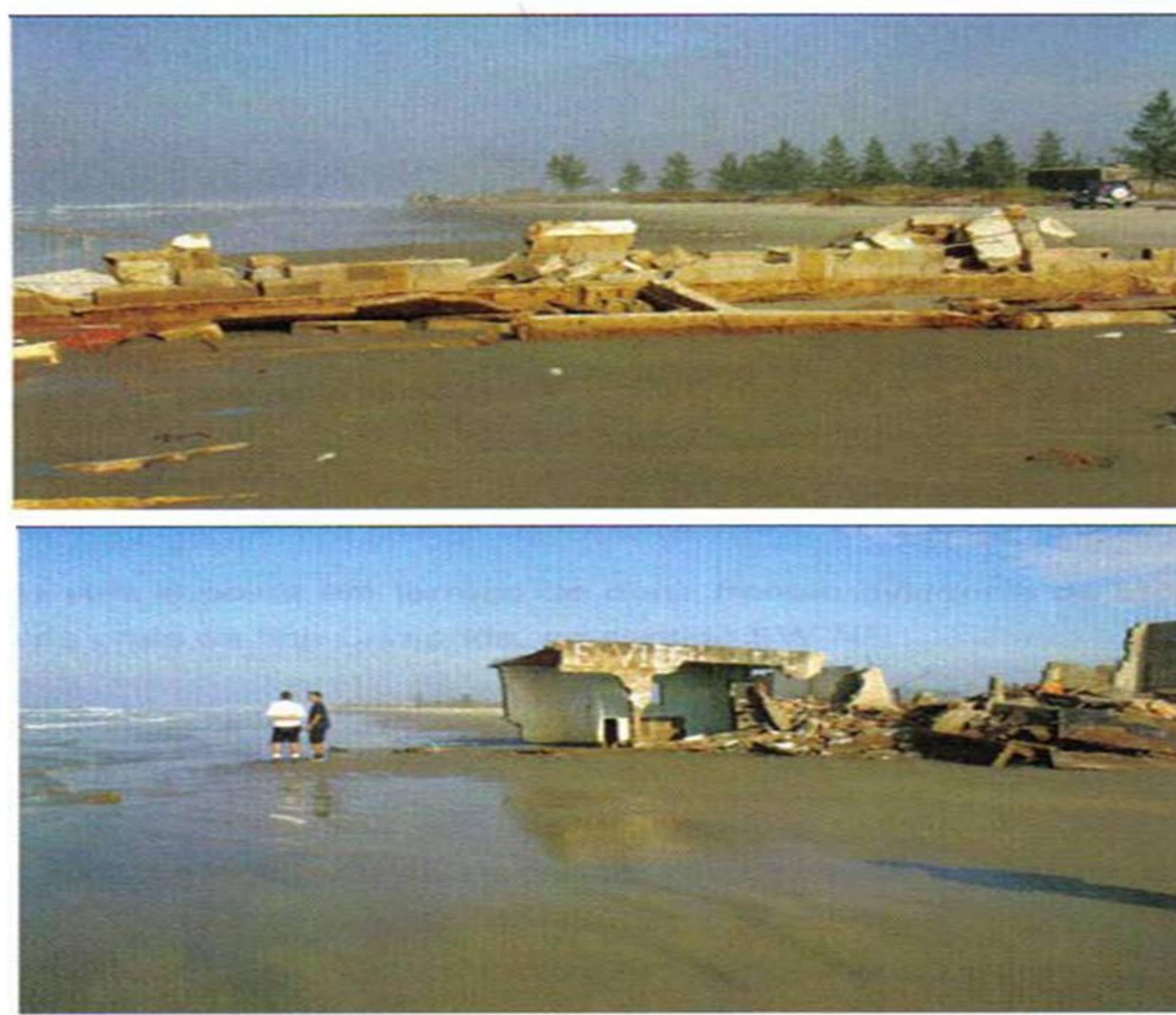
Figura 3: Erosão costeira, com construções na face praias Fonte: Becegato & Suguio (2007). Revista Ung de Geociências
