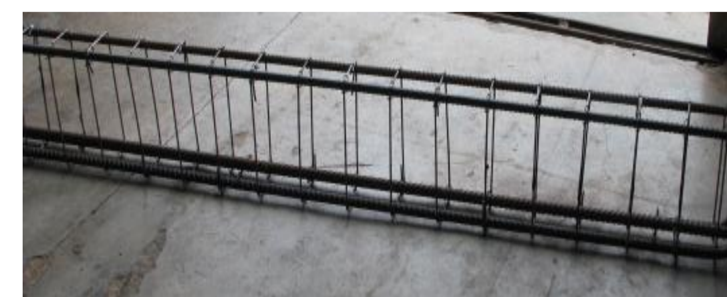
Fotos de estribos sendo montados
