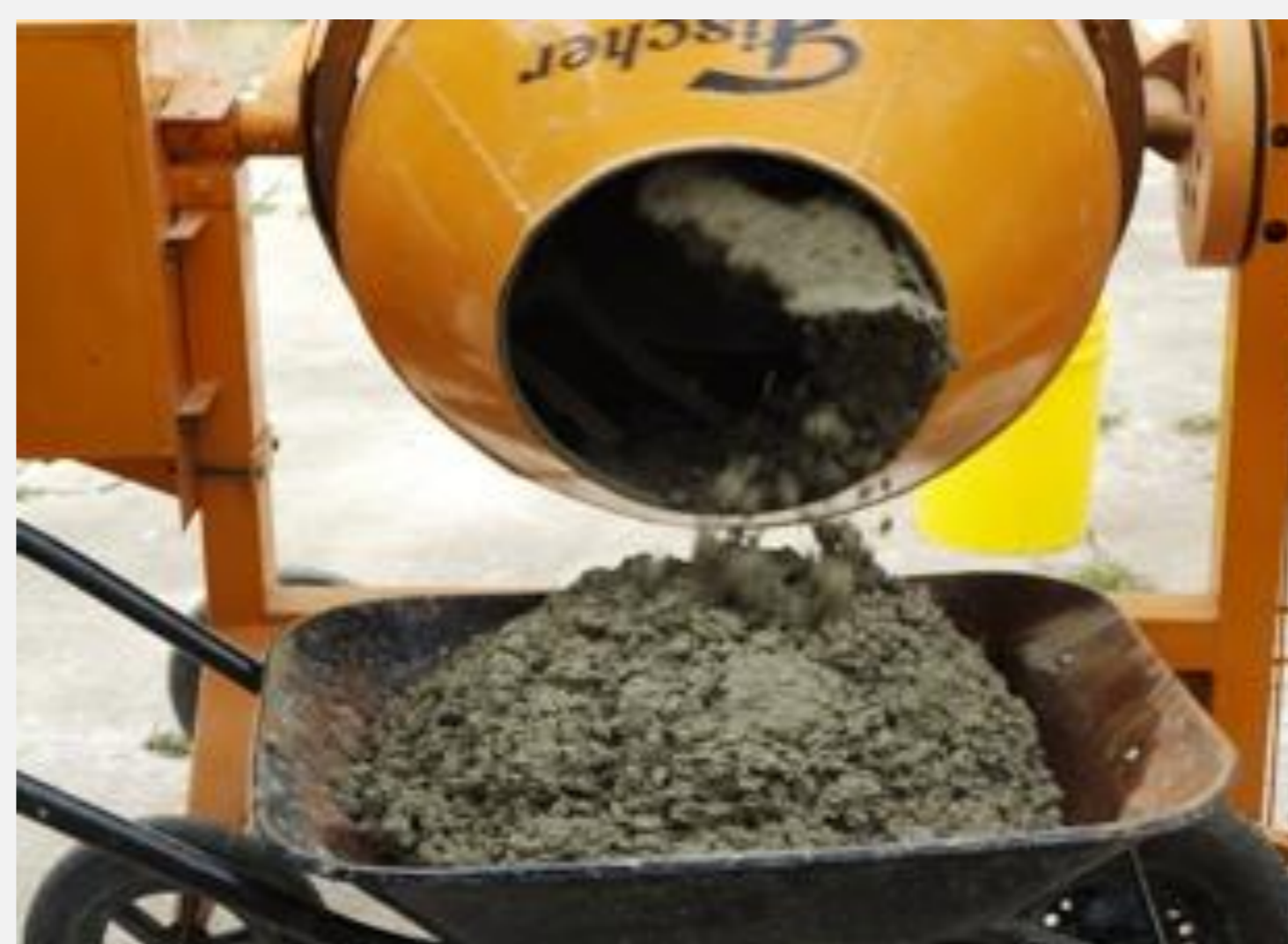
Figura 1 – Produção do concreto.
