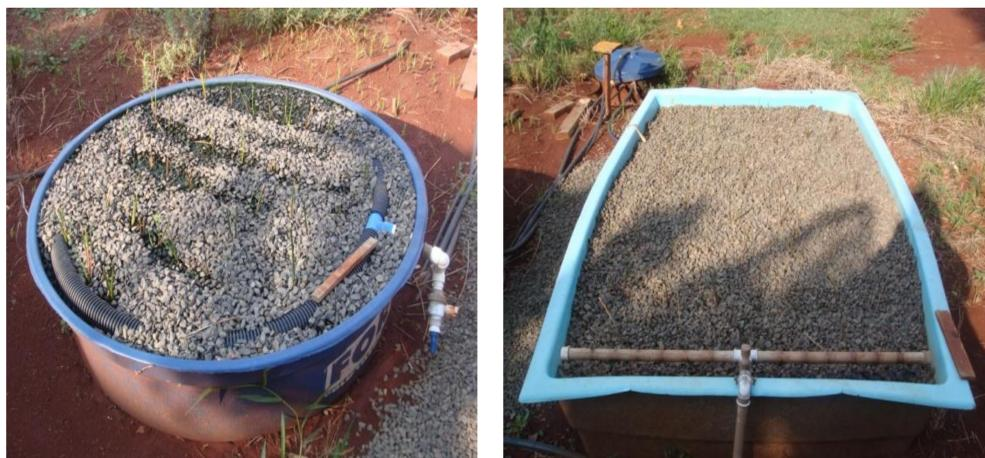
Figura 1 – Leitos cultivados de fluxo vertical ascendente e de fluxo horizontal descendente.
