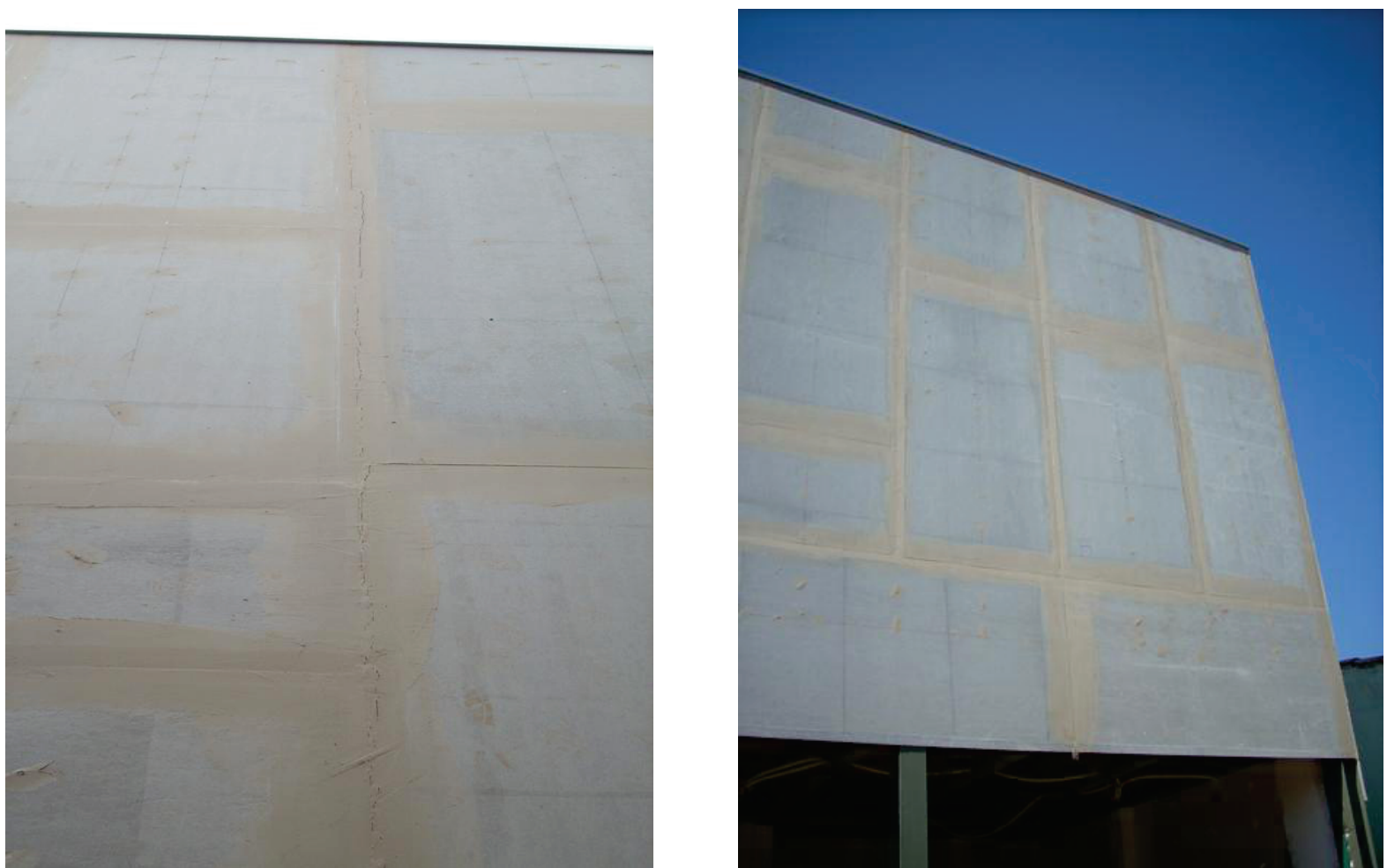
Figuras 4 e 5 – Tratamento de juntas em placas cimentícias com incidência de fissuras. Fonte: SAURO, 2009
