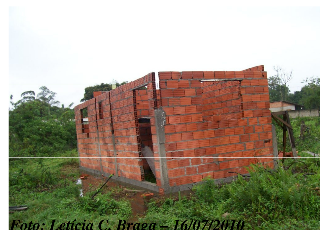
Foto: Letícia C. Braga – 16/07/2010 Construção em área de expansão do Bairro
