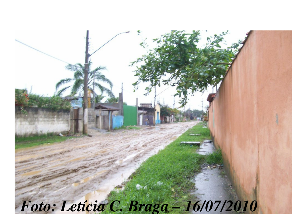
Foto: Letícia C. Braga – 16/07/2010 Rua sem infra-estrutura
