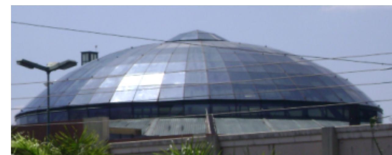
Figura 3: Cúpula de placas de vidro na cobertura do shopping Iguatemi em Campinas, esta estrutura possui cerca de 30 metros de diâmetro.
