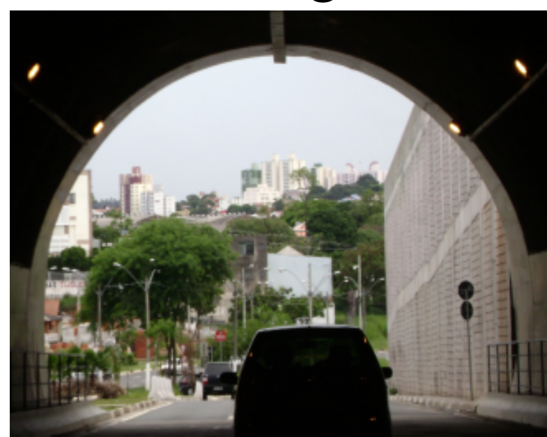
Figura 1: Arco bi-articulado em concreto armado presente em um túnel de uma avenida de Campinas.
