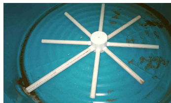
Figuras 2 e 3 – Detalhes do interior do filtro UASB mostrando o separador de fases (sólido, líquido e gasoso) construído em inox e o sistema de entrada e distribuição do efluente no FA
