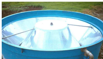
Figuras 2 e 3 – Detalhes do interior do filtro UASB mostrando o separador de fases (sólido, líquido e gasoso) construído em inox e o sistema de entrada e distribuição do efluente no FA
