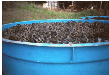
Figuras 4 e 5 – Fotos do Meio Suporte (oring) que é utilizado como enchimento do Filtro Anaeróbio
