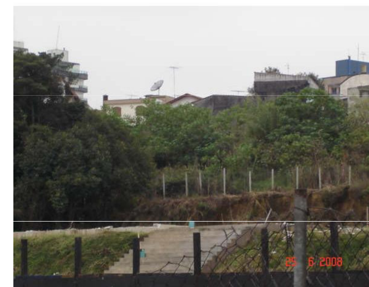
Corte de encosta na área central de Guarulhos-SP
