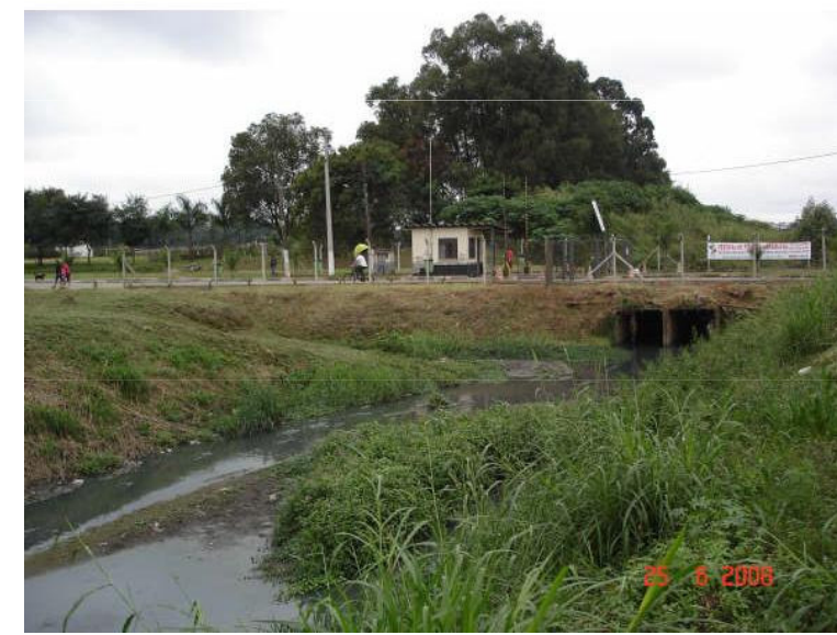
Esgoto a céu aberto nos limites da Estação Tietê - Guarulhos-SP
