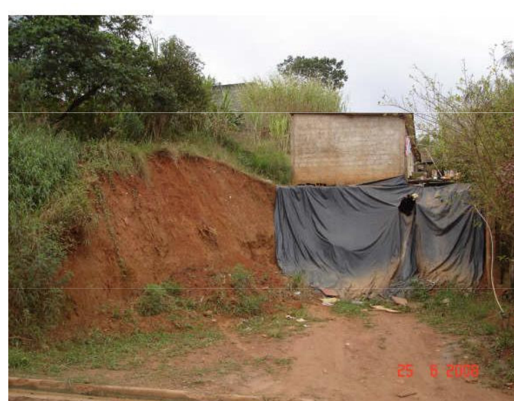
Casa com risco de Escorregamento no Parque Residencial Bambi - Guarulhos-SP
