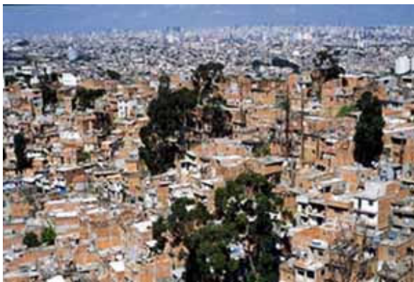
O território fragmentado e mutante de São Paulo em quatro momentos. Momento 4: a Serra da Cantareira, área de proteção ambiental, ocupada pela cidade ilegal/real. Foto Nelson Kon
