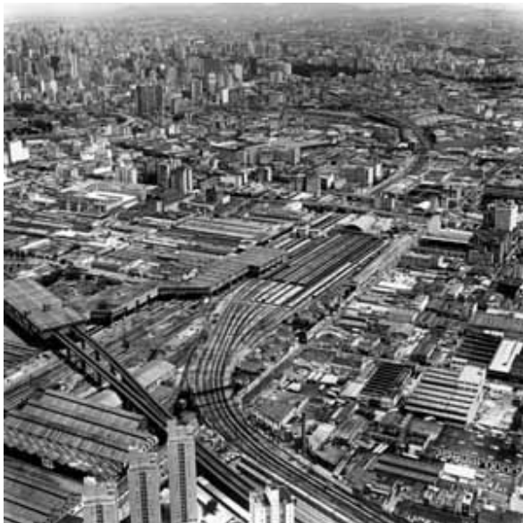
Espaços residuais e terrenos vagos ao longo da orla ferroviária: 60% do Brás, antigo bairro industrial, é estimado como desocupado. Foto Nelson Kon
