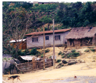
Figura 1: Comparação entre casa de alvenaria e pau-a-pique. Retirado do RTC de Cangume.
