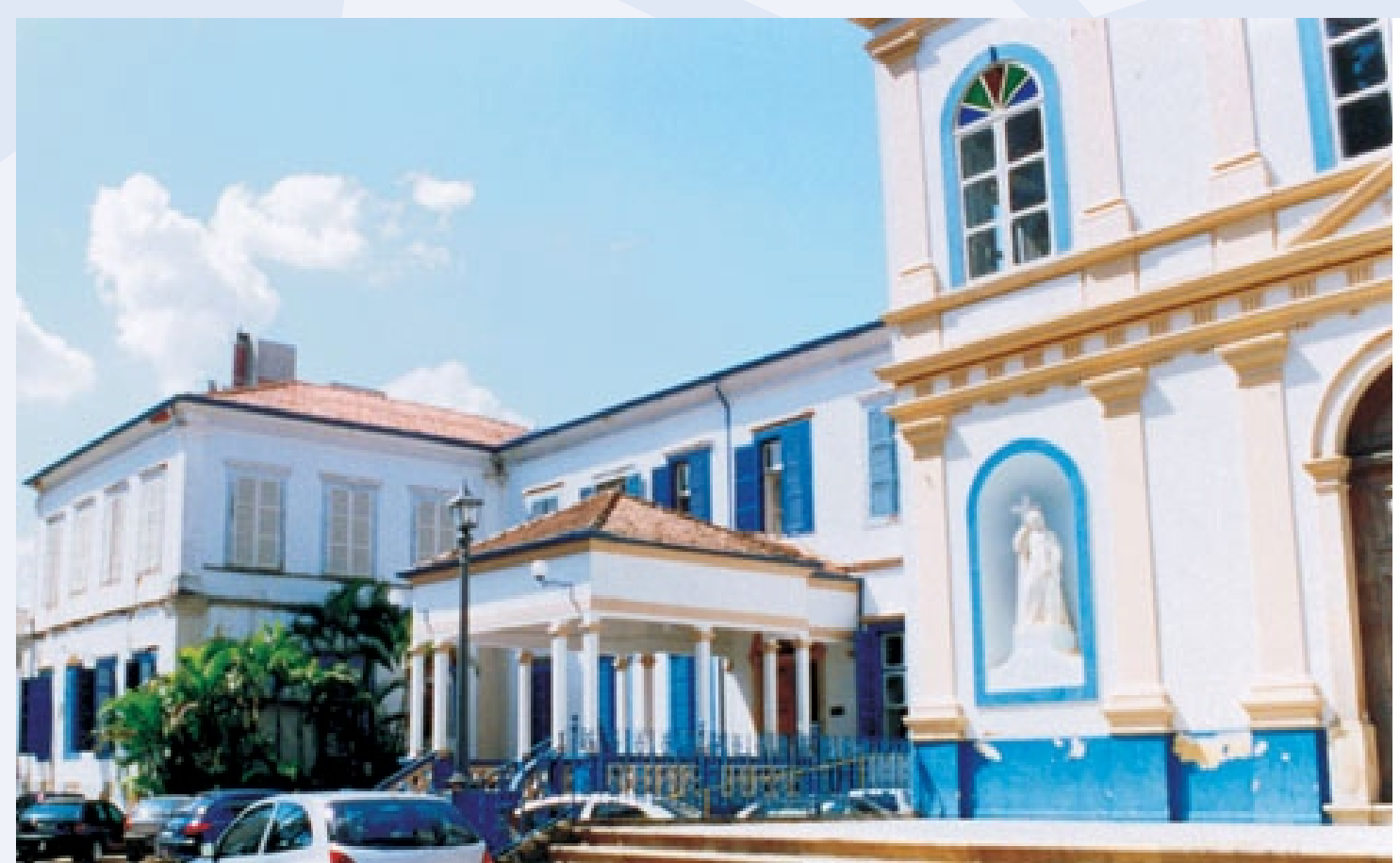
Frente da Santa Casa de Misericórdia de Campinas atualmente
