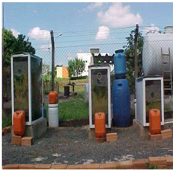
Valas de filtração de 0,75; 0,50 e 0,25m de altura da camada de areia
