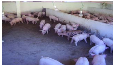
Figura 1. Prédio de Creche (Salto-SP).
