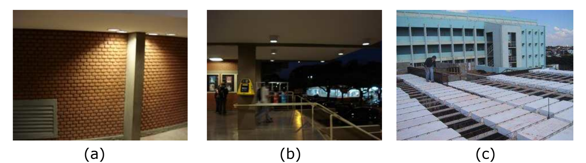
Figura 5 - (a) Pilar de concreto no Ciclo Básico. (b) Viga em balanço no Ciclo Básico. (c) Laje em construção no prédio da FEC.
