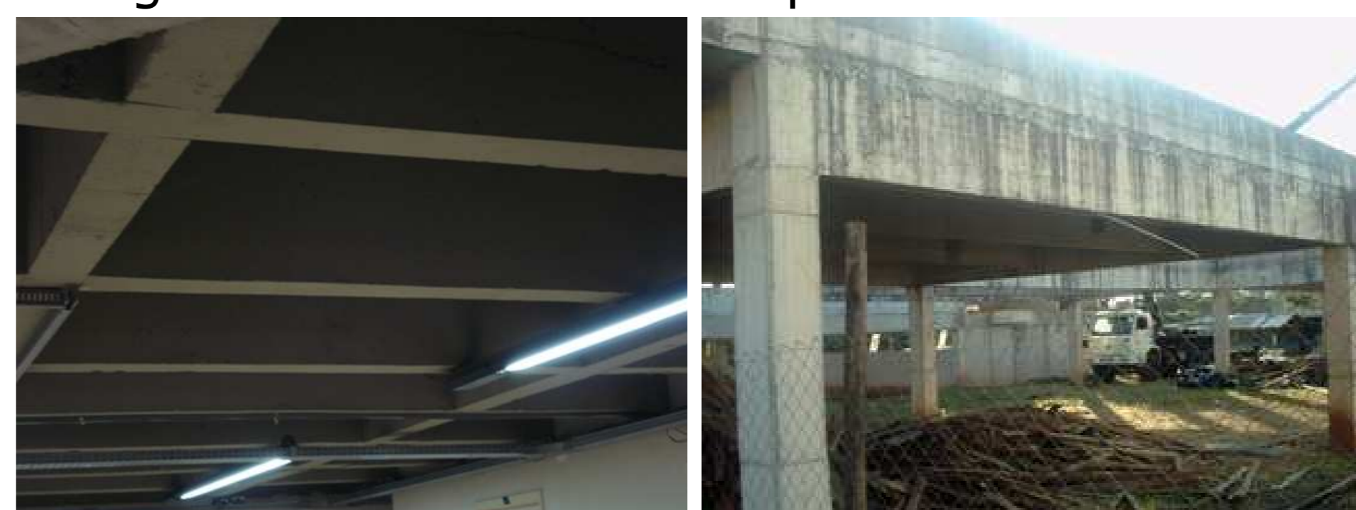
Figura 3 - (a) Grelha no IMECC. (b) Pórtico em obra em frente ao CEL.
