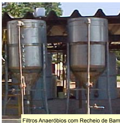
Filtros Anaeróbios com Recheio de Bambu
