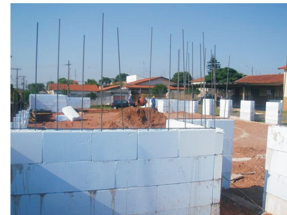
Figura 2 - Início da obra, a direita, e elevação das paredes (Isocret)
