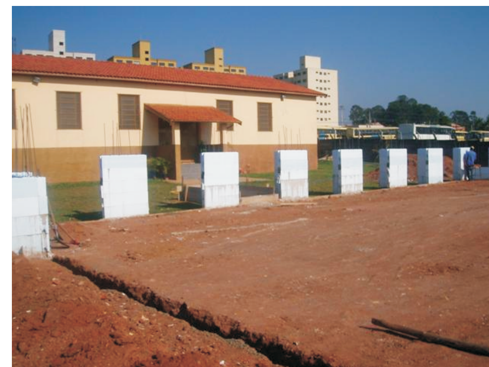
Figura 2 - Início da obra, a direita, e elevação das paredes (Isocret)
