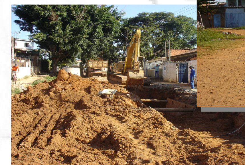
Rua (70) Silva Jardim. Implantação da rede de esgoto, Jardim Amanda II.
