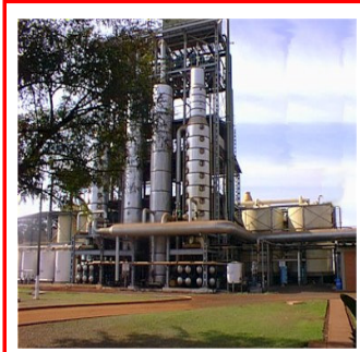
Fig 2. Torre de destilação de uma usina sucroalcooleira
