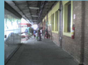
Fig.4: Lateral do Museu Estação Ciências da USP em São Paulo.
