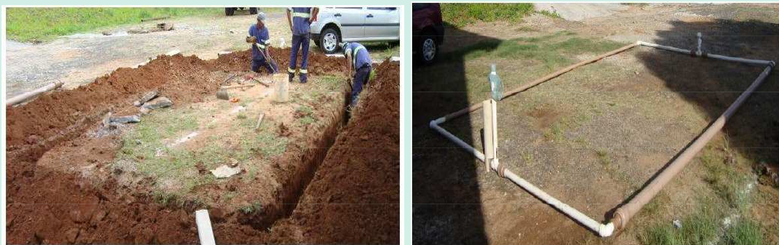
Figura 02 e 03: Fotos da montagem da bancada experimental
