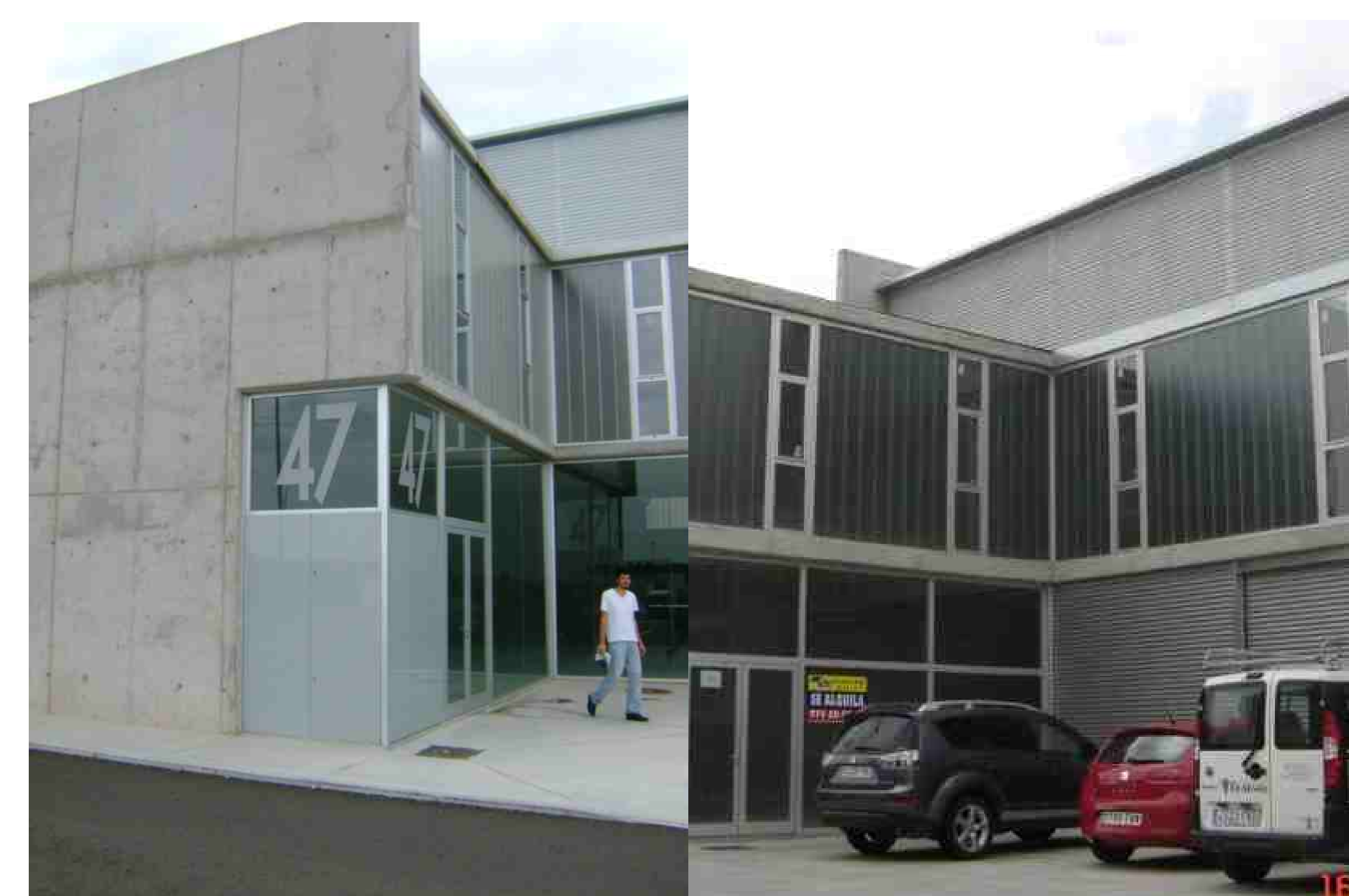
Edifícios para escritórios e serviços em construção pré-moldada na Plataforma Logística de Zaragoza. Detalhes construtivos favorecem a iluminação natural e a flexibilidade dos módulos
