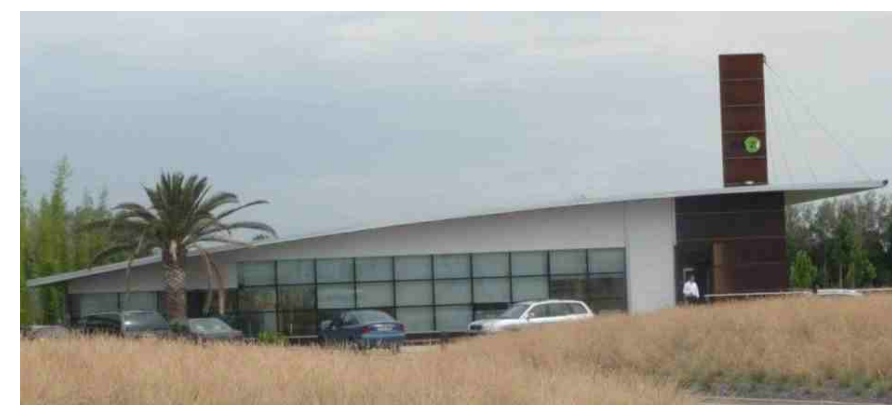
Sede administrativa da Plataforma Logística de Zaragoza, Espanha. Utilização de iluminação natural, módulos pré-fabricados e materiais certificados.
