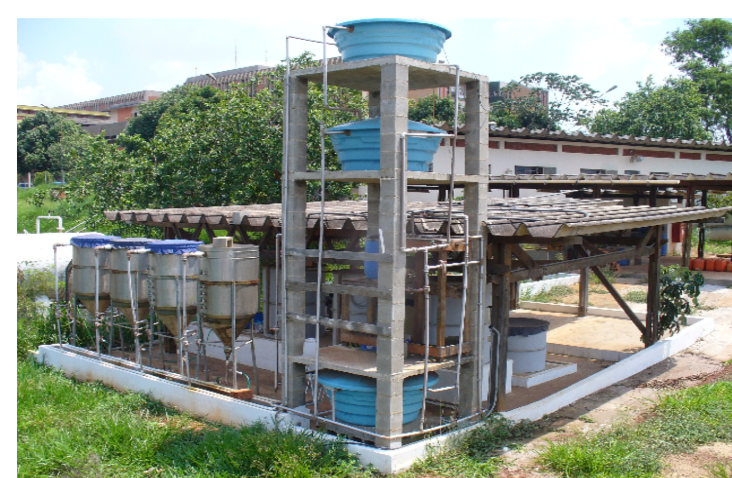
Figura 2 Vista geral do projeto
