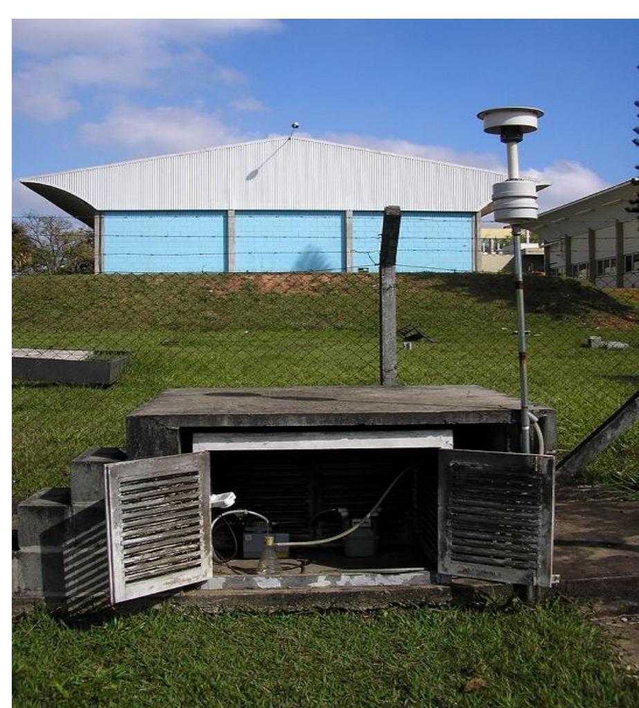
Fig. 1 – Estação captadora de M.P.
