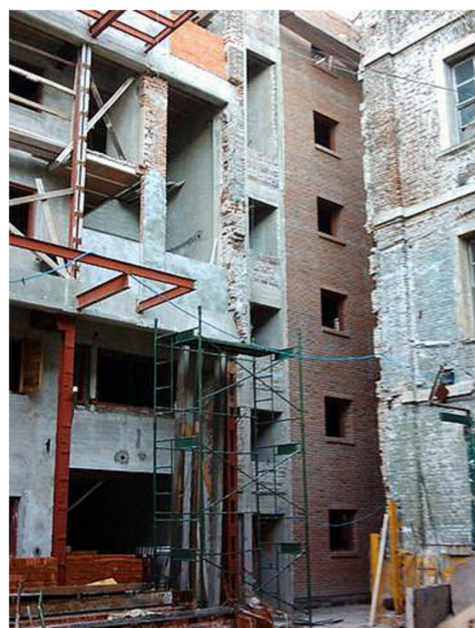
Construção da Cooperativa El Molino
