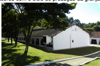
Figura 1: Galpão de criação da granja avaliada e evaporador utilizado em um dos tratamentos (na lateral).
