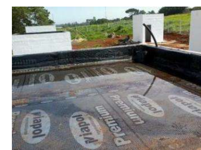
Instalação das coberturas
