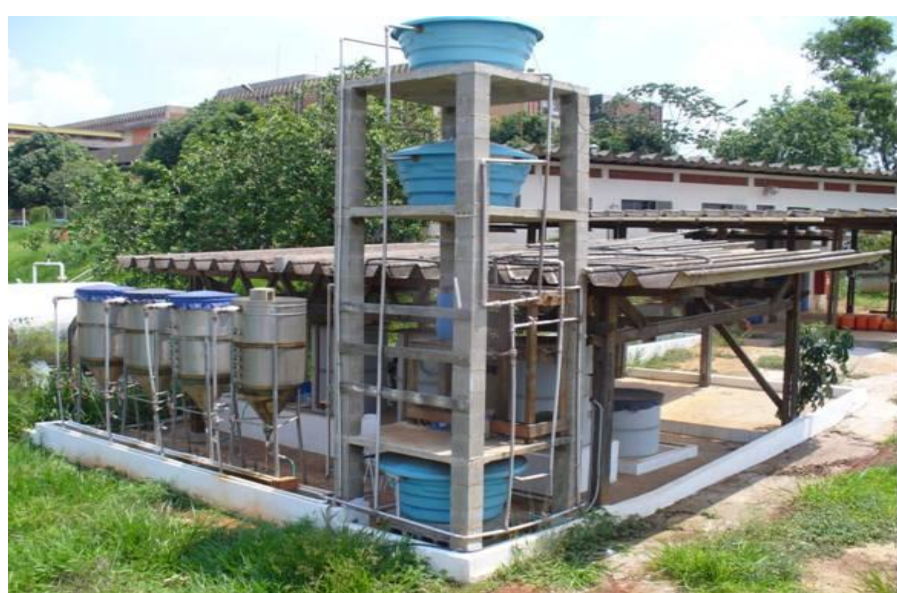
Figura 1: Vista geral das instalações da pesquisa
