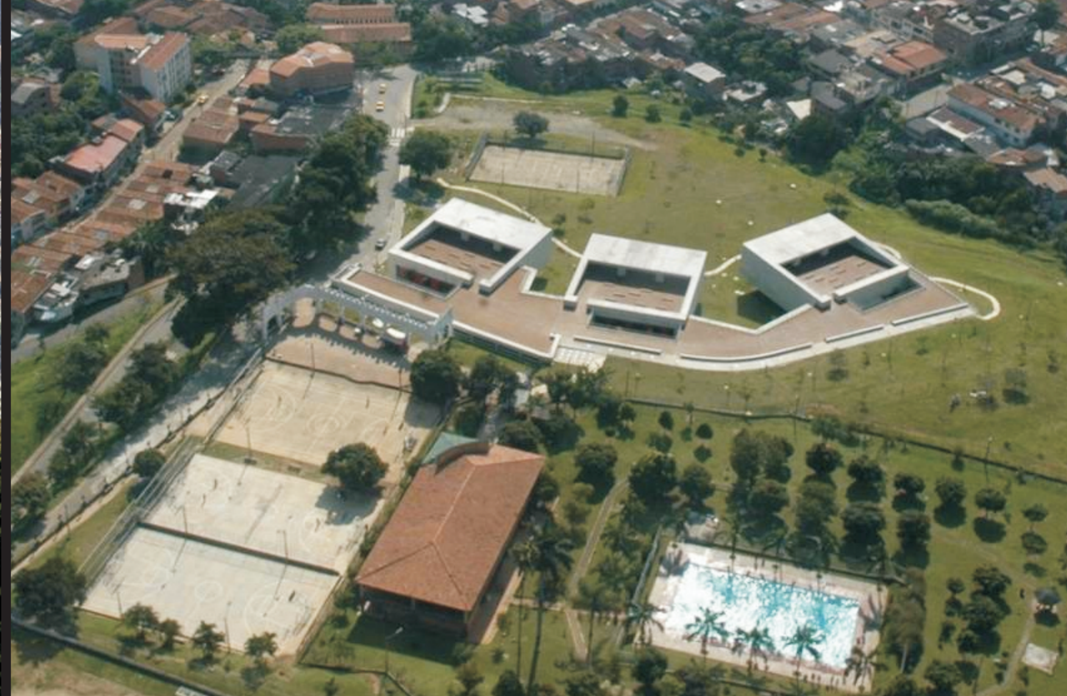
Imagem: Plataforma Arquitectura, http://www.plataformaarquitectura.cl/2008/02/08/parque-biblioteca-leon-de-grief-giancarlo-mazzanti/
