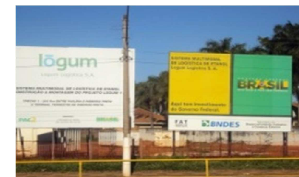
Figura 5: Obras do trecho 1 (Ribeirão Preto – Paulínia) do Sistema Logístico Multimodal. Foto: Gabriel Olimpio
