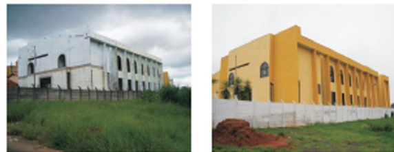
Figura 4 – À direita, paredes concluídas e à esquerda obra finalizada Fonte: Isocret do Brasil
